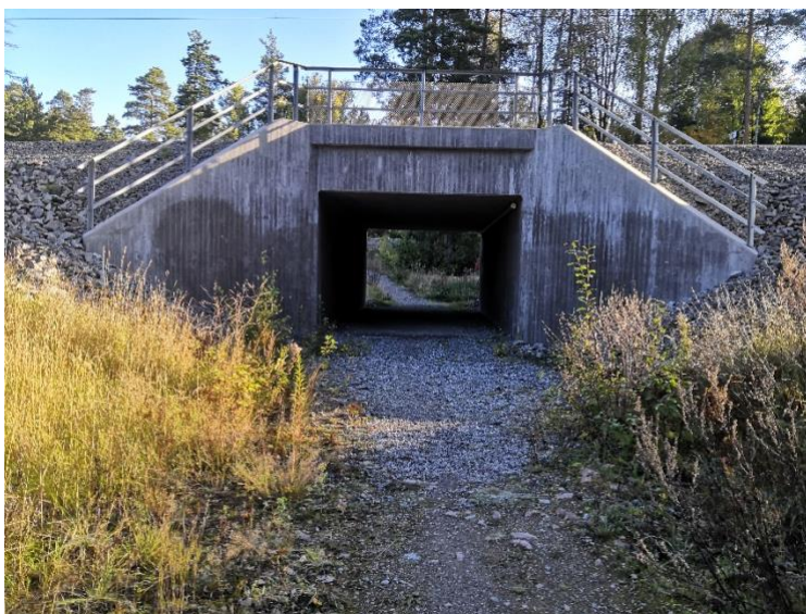
Figur B: 3. Passage 1. Passagen är en port under järnvägen utan bullerskärmar.
