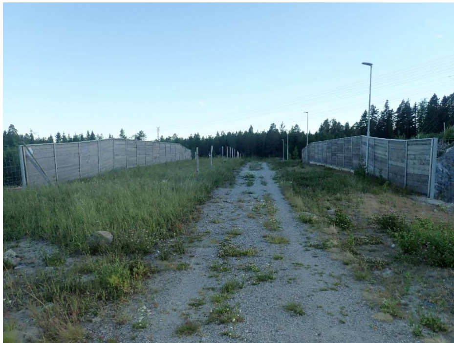
Figur 17. Passagen över E4 söder om Sundsvall. Foto: Trafikverket.
