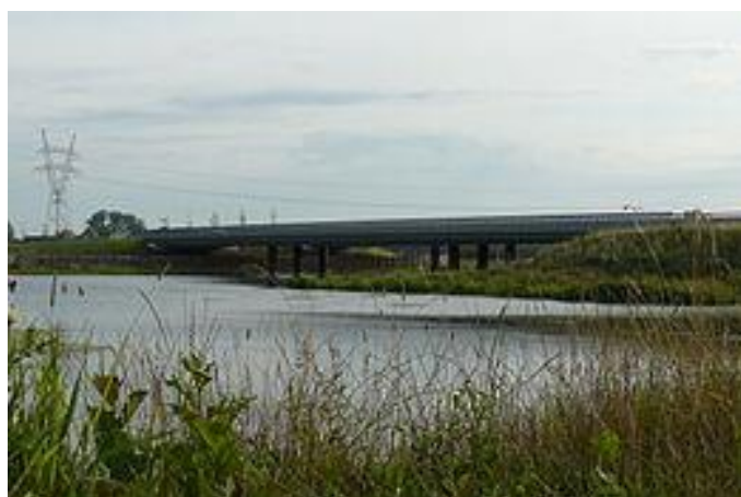
Figur 3. Väg N236 i Nederländerna med möjlighet för djur att passera under vägen.
